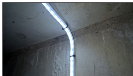
durch Steckdübel schnell befestigt im Schachtkopf flexibel um die Ecke
